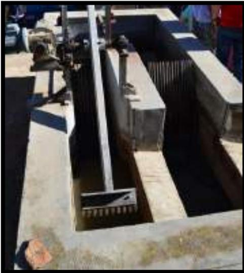
**Pretratamiento.** Es la separación de sólidos en suspensión o flotantes de gran tamaño y densidad (trapos, palos, hojas, plásticos, cuerpos de gran volumen, arenas, piedras y ciertas grasas), que llegan al colector de entrada de la estación depuradora y cuya presencia en el agua podría ocasionar grandes alteraciones en conducciones y bombas de la instalación o impedir otras fases del tratamiento. Para ello se realizan los siguientes procesos:
