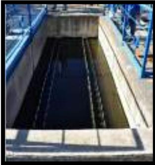
**Estabilización de los fangos.** Se utiliza para eliminar la materia orgánica presente en ellos. Este proceso se puede realizar por vía aerobia o anaerobia. En la estabilización aerobia se produce la oxidación de la materia orgánica presente en los fangos, para lo cual se necesita un aporte de oxígeno, y se airean los fangos de forma que los microorganismos puedan actuar.
