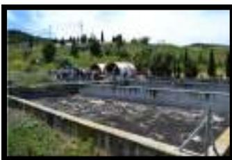
**Deshidratación.** Se lleva a cabo mediante secado, filtro prensa y centrifugación, para eliminar el agua que todavía contienen los fangos. Éstos pueden ser recogidos para su traslado a vertederos, o sufrir procesos de incineración o fabricación de compostaje para su posterior
